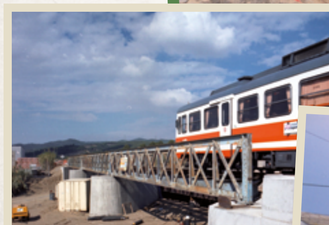
Imatge paradigmàtica dels nous temps de renovació: un dels trens dièsel modernitzats travessant el pont de Piera, en procés de renovació. Arxiu FGC (1996).
