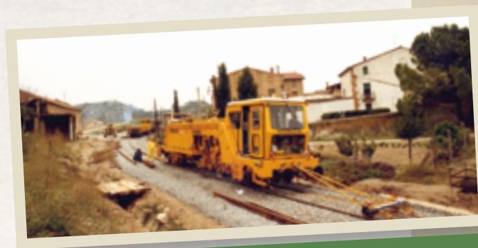
Treballs de renovació de vies a la línia, una de les prioritats de la nova companyia pública. Arxiu FGC (1982)
